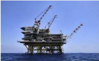
**Plataforma Fixa:** Usada para campos com até 300 metros de profundidade, é feita de estruturas modulares de aço e instalada com estacas no fundo do mar.
