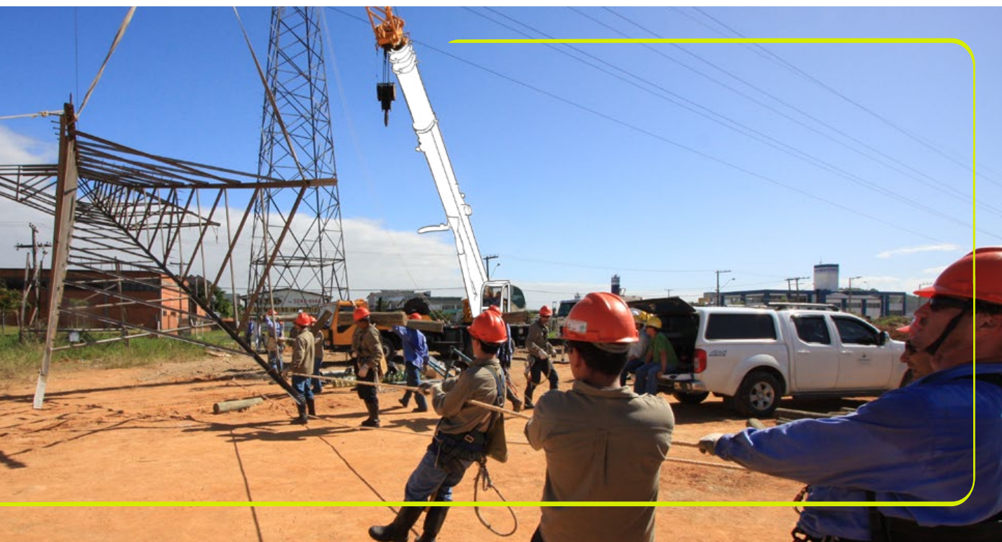
Troca de torres de transmissão. Acervo Eletrobras CGT Eletrosul.
