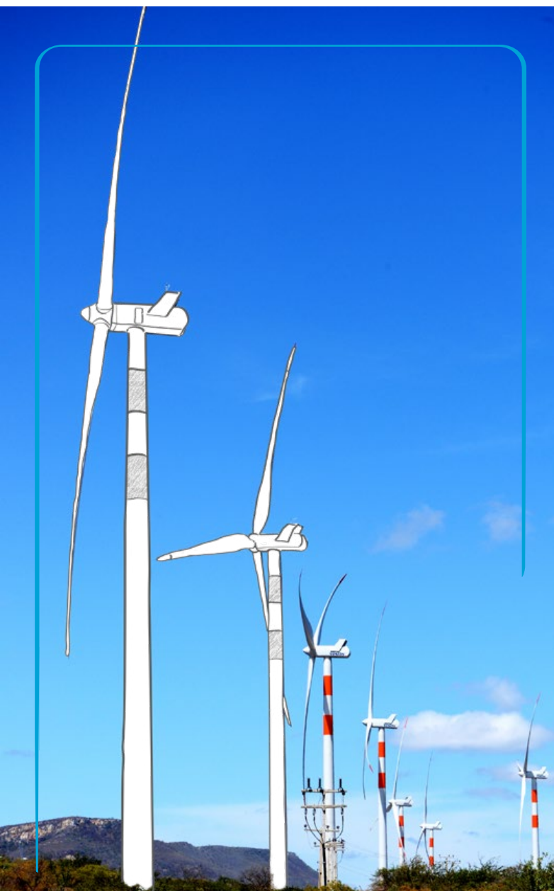
Complexo Eólico Sento Sé. Acervo Eletrobras Chesf / Severino Silva.
