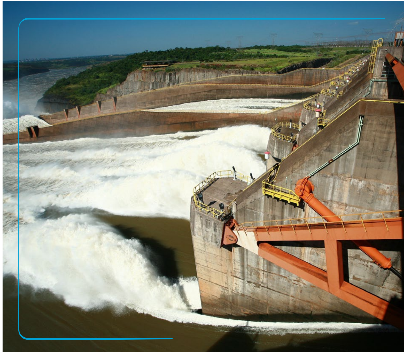
Panorama do trampolim do vertedouro da usina hidrelétrica de Itaipu. Acervo Itaipu Binacional / Caio Coronel.
