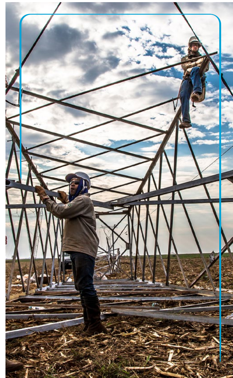
Manutenção em torre de transmissão. Acervo Eletrobras Furnas / Daniela Monteiro
